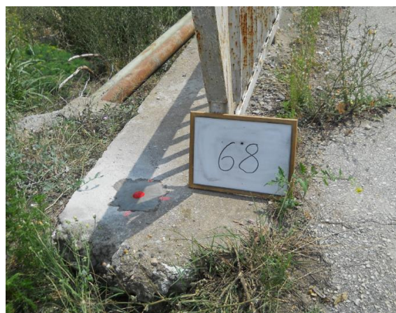
Фигура 6. Стабилизиране на гъбовиден болт в съоръжения
