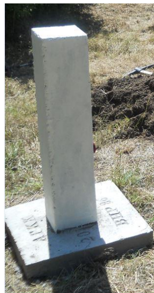
Фигура 3. Изработване на бетонов стълб на показалец към ВНР I и II степен
