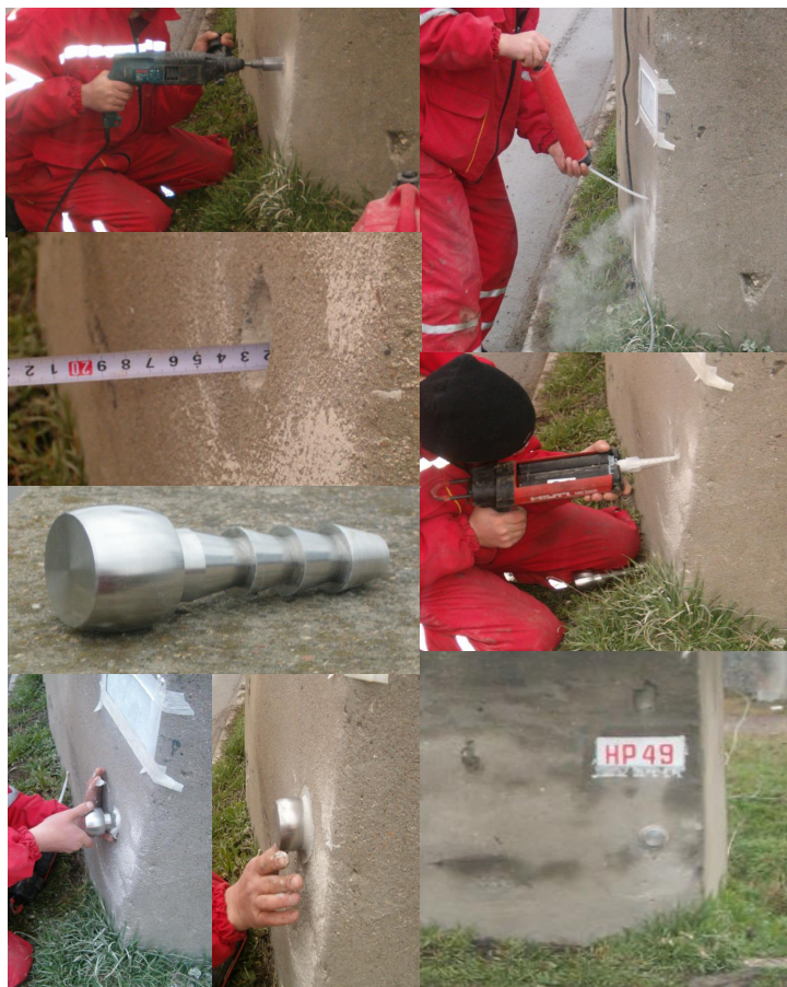
Фигура 4. Етапи от стабилизиране на стенен болт
