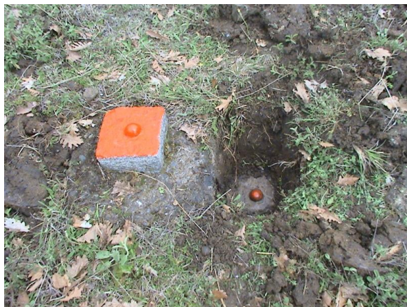
Бетонов блок с подземен и надземен нивелачен знак (код 53)
