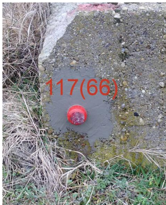
Фигура 5. Стабилизиране на болтове в сгради и съоръжения
