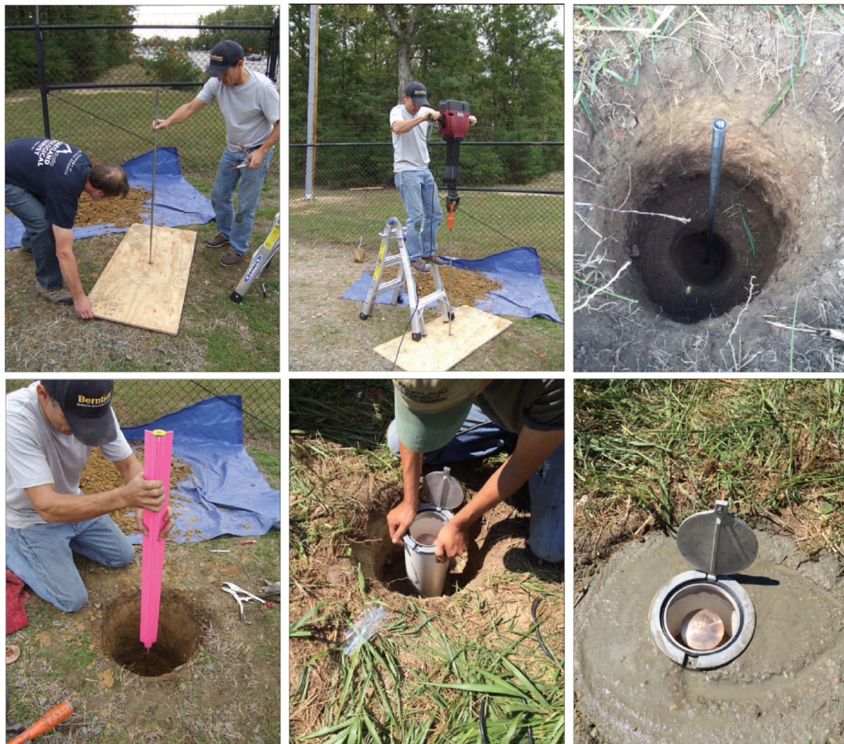
Фигура 2. Етапи от изграждане на дълбочинен репер
