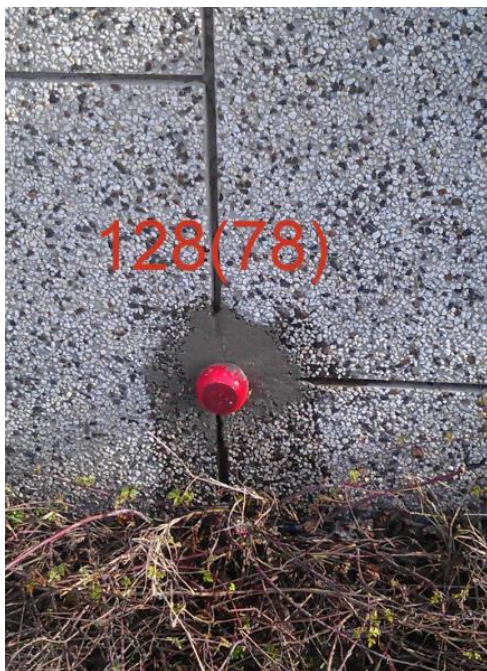
Фигура 5. Стабилизиране на болтове в сгради и съоръжения
